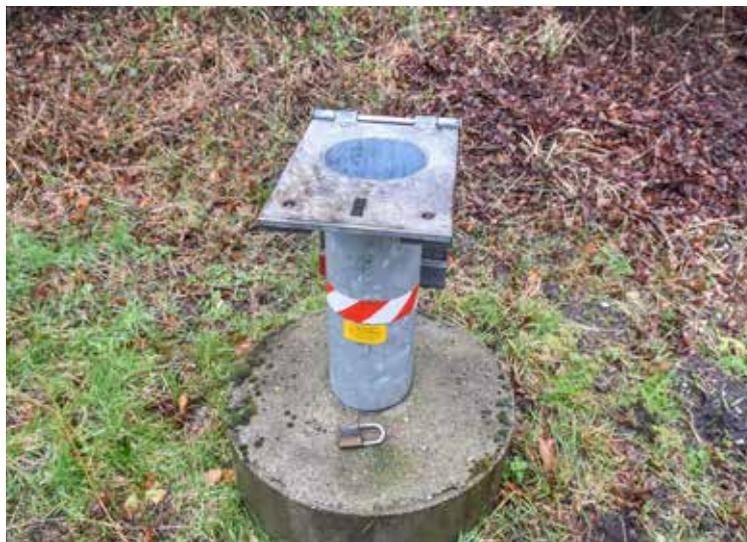
Das LLUR überwacht die Eigenschaften des Grundwassers in Schleswig-Holstein. Dazu dienen Proben, die an Grundwassermessstellen gezogen werden, wie in Elsdorf-Westermühlen, Kreis Rendsburg-Eckernförde.
