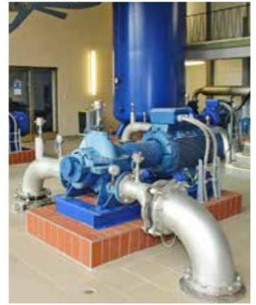
Eine Verteilerpumpe, hinten der Vorkessel
