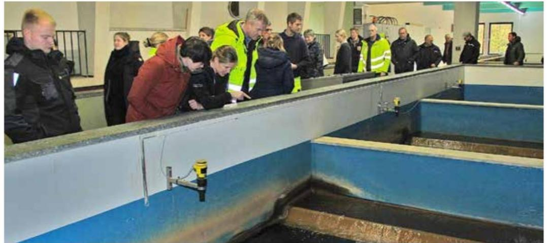
In den Filterbecken wird das Wasser durch eine 2 m hohe Kiesschicht geleitet, Eisen und Mangan setzen sich ab.
