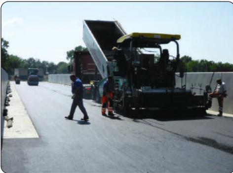
Abbildung 8: Ausführung einer Fahrsi- lofläche mit Walzasphalt
