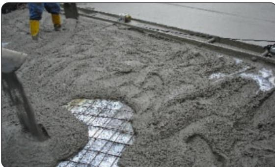
Abbildung 6: Einbau einer neuen Schicht „Opferbeton“ aus Beton mit Haftmittel und Bewehrung mit Hilfe einer Rüttelbohle.
