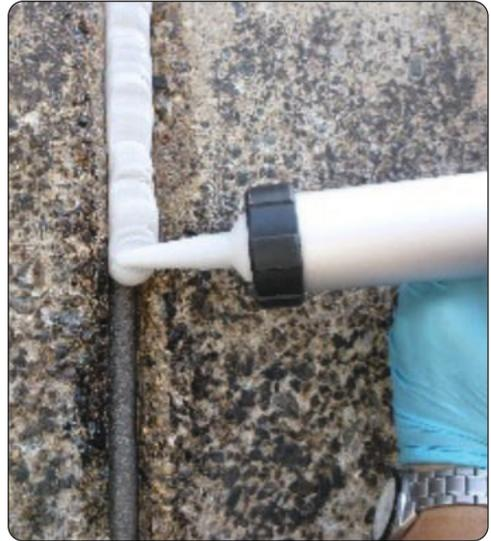
Abbildung 14: Fugenmasse einbringen
