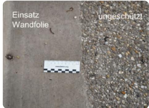
Abbildung 3: Mit Folie geschützter Wand-/Bodenbereich ist deutlich zu erkennen.
