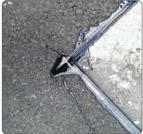
Abbildung 12: Wand – und Bodenfuge mit Heißvergussmasse verschlossen
