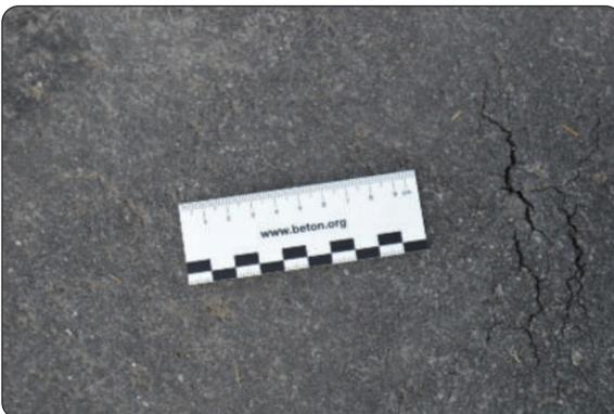
Abbildung 10: Aufplatzen der As- phaltdeckschicht aufgrund man- gelhafter Verdichtung
