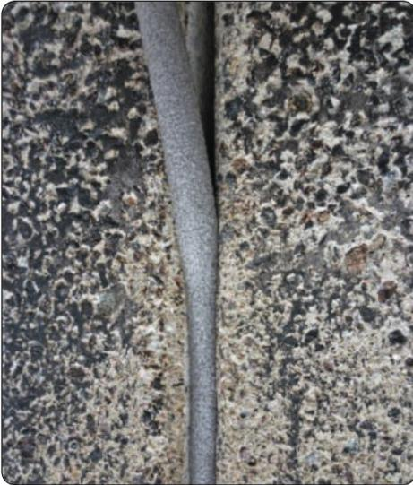
Abbildung 13: Fugenfüllschnur (Moosgummi) einbringen
