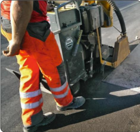
Abbildung 11: Aufweitung der Fuge Wand/Boden zum anschließenden Vergießen mit Heiß- oder Kaltvergussmasse
