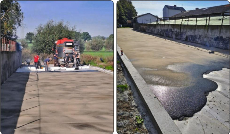
Abbildung 7: Einbau einer Deckschicht aus Gussasphalt erfolgt auf einer Trennlage (Vlies).
