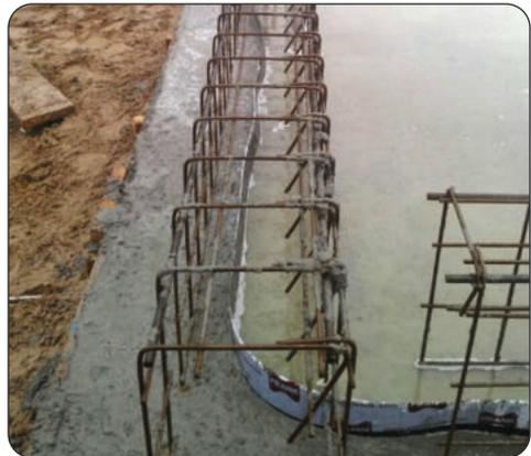
Abbildung 16 und 17: Bei monolithisch geschütteten Wänden / Aufkantung ist ein DIBt zugelassenes Fugenband / Fugenblech einzubauen.
