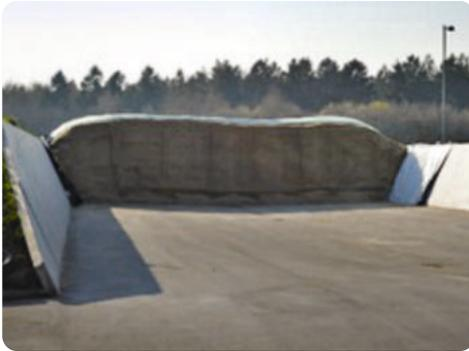
Abbildung 2: Verwendung einer Wandfolie im Fahrsilo
