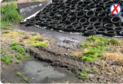
Um Sickersäfte an allen Seiten der Silageplatte aufzufangen und ordnungsgemäß zu entsorgen, müssen Entwässerungsrohre **immer** bis hinter das Silo verlegt werden.
